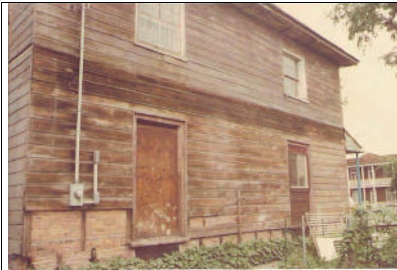
**Fig. 31** Façade latérale sud de la villa Ringfield en 1983. Au bas, la partie manquante du revêtement laisse apparaître la structure en brique et le bois de clouage qui permet de fixer les planches au mur. Cette photographie fait aussi voir ce qui semble être la plus ancienne couleur du revêtement de bois, un ocre jaune.
