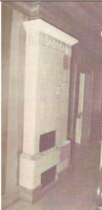
**Fig. 47** Au 18, rue Mont-Carmel, un poêle d'applique, la version encastrée des « poêles russes » produits à Québec au milieu du 19<sup>e</sup> siècle.
